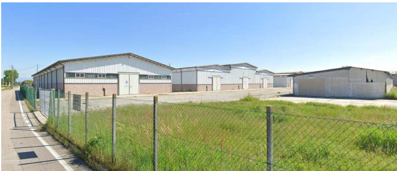
Vista degli edifici lato sud
