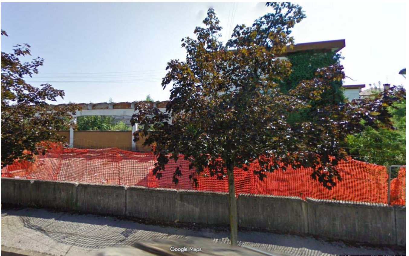
Vista degli edifici lato ovest
