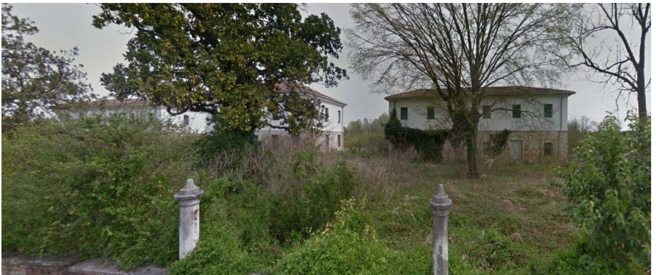
Vista degli edifici lato ovest
