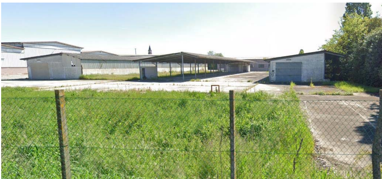
Vista degli edifici lato ovest
