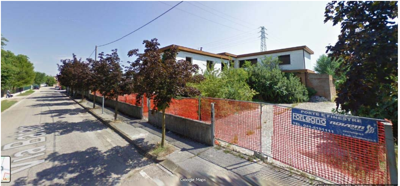
Vista degli edifici lato ovest
